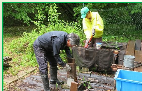
ウッドデッキ解体
